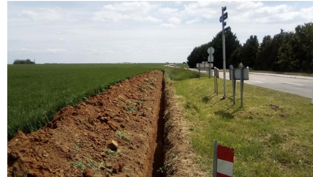
Photo 3 : Tranchée pour le passage de réseau électrique HTA à partir d'une pelle mécanique (Source : VALOREM)
