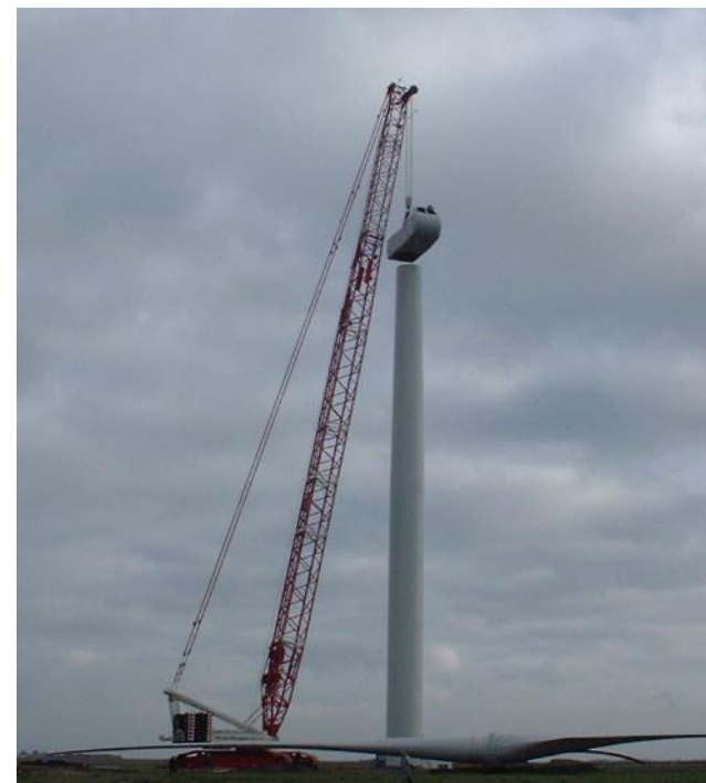
Photo 52 : montage de la nacelle
