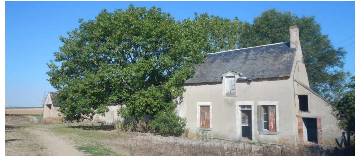
Photo 13 : bâtiments inhabités et déclassés de la Maison Neuve en bordure nord de la zone d'implantation potentielle
