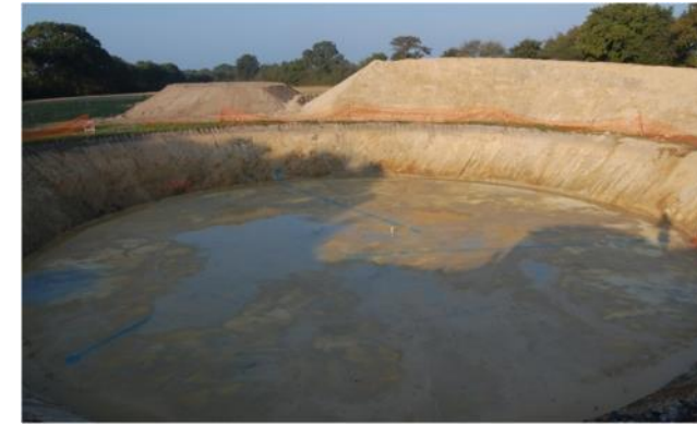
Photo 48 : excavation pour fondation
