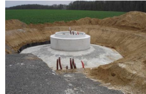
Photo 42 : fondation d'éolienne
