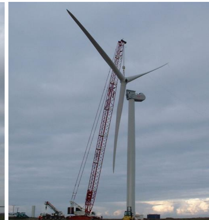
Photo 53 : montage du rotor
