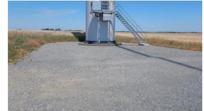
Photo 43 : plateforme au pied d'une éolienne
